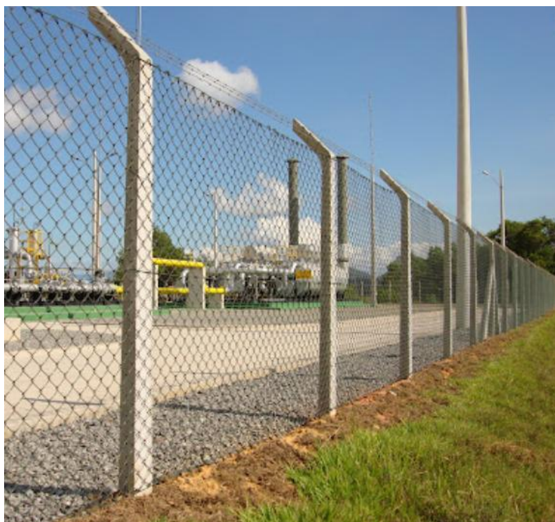
Figura 7: Exemplo de cerca em alambrado com mourões em concreto. Imagens retiradas da internet.
