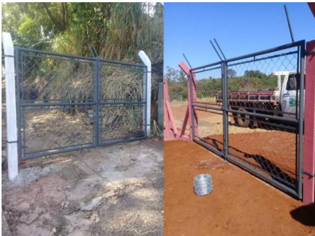
Figura 8: Exemplo de portão em alambrado com tubos circulares nos montantes e travess. Fonte: Imagens retiradas da internet.
